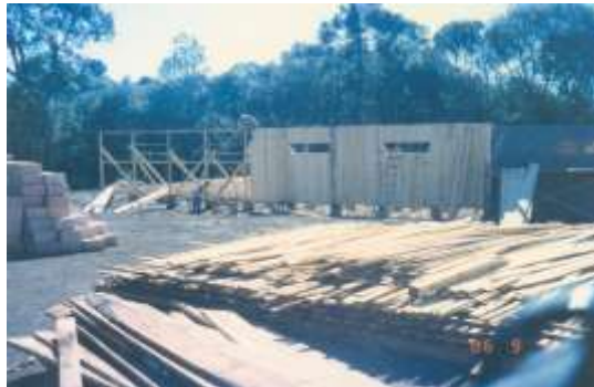
Construção do Kendô-Dojô
