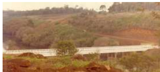
Nova ponte de concreto sobre o Rio Marombas
