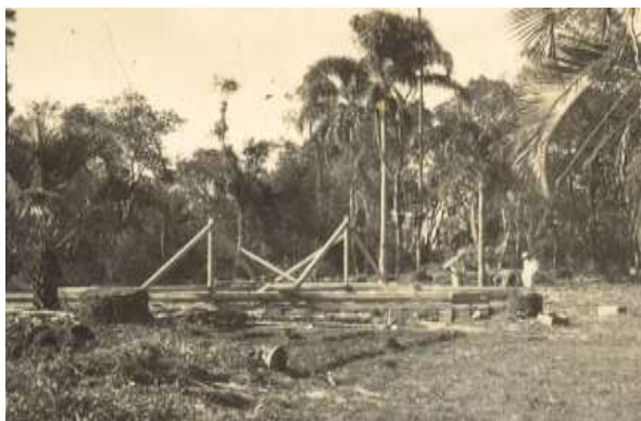
Construção da casa do Sr. Kazumi Ogawa
