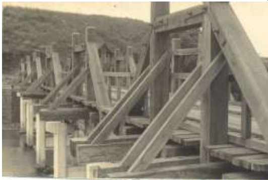
Ponte Rio Marombas
